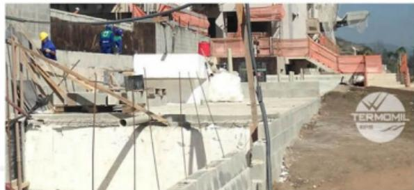
O Geofoam, fabricado pela Termomil, é uma solução para estabilização de solos moles com blocos de EPS (Poliestireno Expandido). Graças às suas propriedades, como baixo peso e boa resistência mecânica, o Geofoam se torna um excelente substrato para utilização em aterros na construção de estradas, além de proporcionar uma execução mais fácil e rápida da obra.
